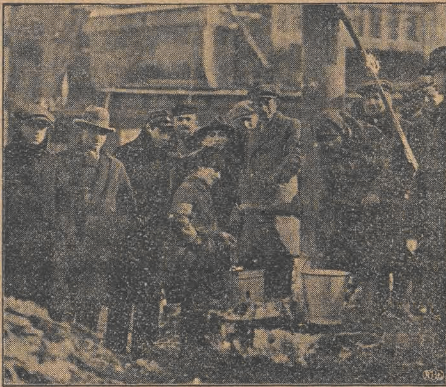
Jak wiadomo, w wielu domach łódzkich zabrakło — wskutek pęknięcia rur — wody. Na zdjęciu — „ogonek wodny” na jednym z podwórz łódzkich.
