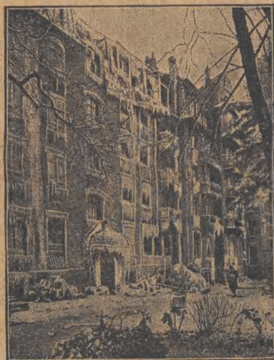
Zgliszczona hotelu „Residence” w Genewie, który niedawno padł ofiarą pożaru.
