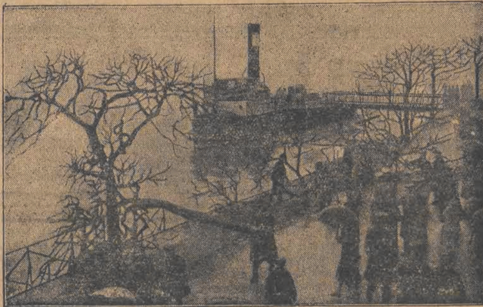
O siłę napierających łódów daje wyobrażenie wypadek, który niedawno wydarzył się na Renie. Stojący u brzegu statek, przymocowany do pni pleców nadbrzeżnych drzew, został przez napór łód woderwany i popłynął z prądem, drzewa zaś — jak to uwidocznione jest na naszej ilustracji — zostały wyrwane z ziemi.
