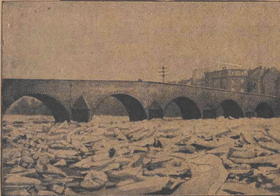
Potęga napierających lodów, którymi obecnie pokryte są wszystkie rzeki środkowej Europy, zagraża nawet najsolidniejszym mostom. Na zdjęciu: kamienny most na rzece Nahe (dopływ Renu) poważnie zagrożony przez napór kry.
