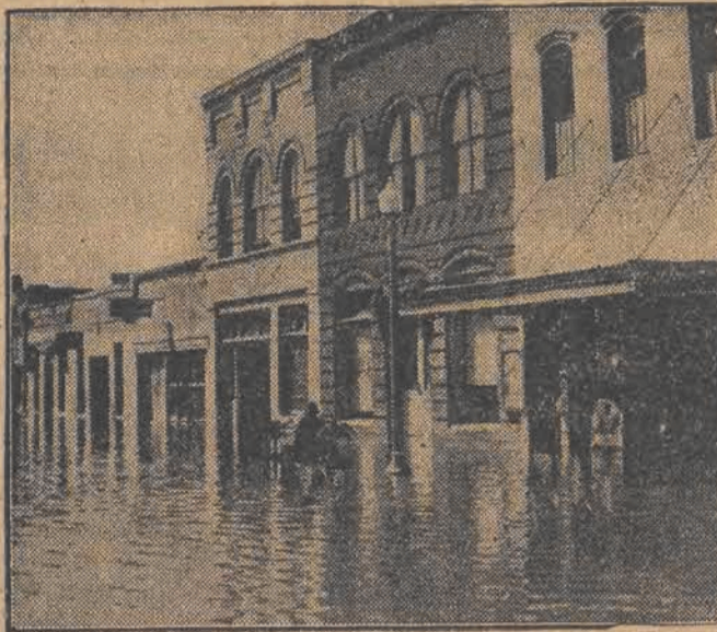
Ulica w stanie Georgja zalana wodą.
