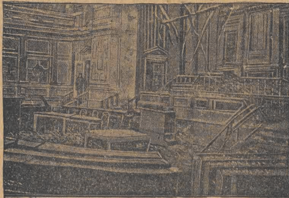
Zniszczona przez płomienie główna sala posiedzeń.
