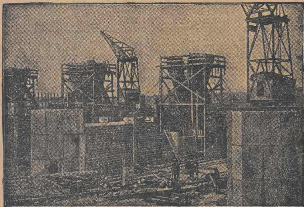
W Holandji trwają — jak wiadomo — już od szeregu lat prace nad osuszeniem jeziora Zuider. Olbrzymie zadanie wymaga olbrzymiego nakładu pracy, obecnie budowane są tam w tym celu ogromne śluzy. Na zdjęciu: prace w teraźniejszym stadjum.
