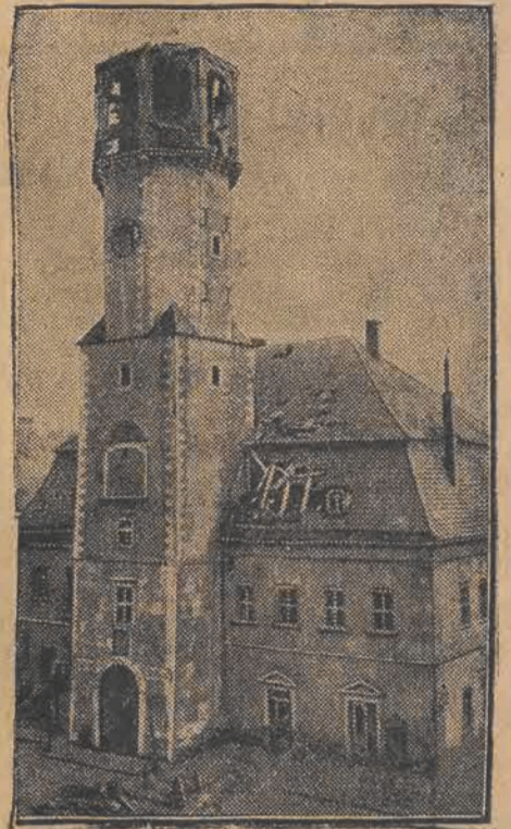
Starożytny ratusz w Greiffenbergu (Śląsk) zniszczony został przez pożar. Na zdjęciu ratusz, którego zniszczona przez ogień wieża stanowiła piękny zabytek architektury z XVI stulecia.
