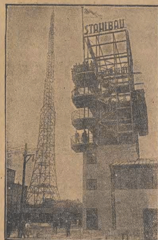
W dniu 25 sierpnia otwarte zostały w Lipsku doroczne targi jesienne. Na ilustracji naszej widzimy projekt budynku ze stali, wystawiony na targach lipskich.
