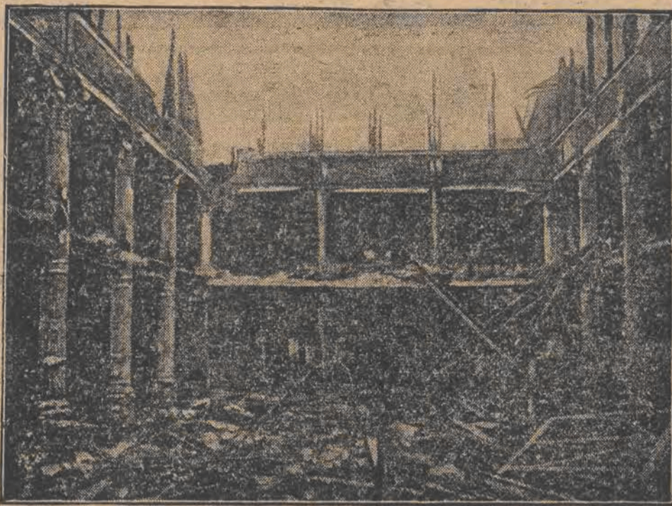
W miejscowości kuracyjnej Eisenach wybuchł pożar, który zniszczył doszczętnie miejscowy dom zdrojowy. Na zdjęciu: zgliszcza po pożarze.
