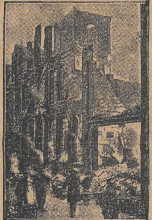
W starym mieście holenderskim Middelburg szalał w tych dniach olbrzymi pożar, który zniszczył 12 wielkich domów. — Na zdjęciu: widok pozostałych po pożarze gruzów.
