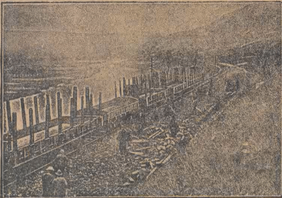
Linja kolejowa Odernhelm—Buchroth w Niemczech zostaje zniszczona, jako linja strategiczna. Dzieje się to na żądanie Francji, która taki warunek podjęła Niemcom przy układach o ewakuację Nadrenii.
