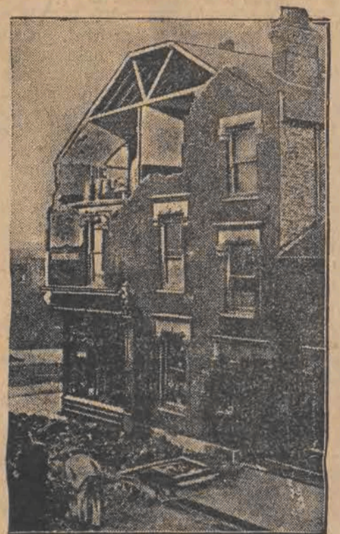
Dach domu w Londynie, zerwany przez szalejący nad tem miastem niedawno orkan. Spadające gruzy zabiły 2 przechodniów.
