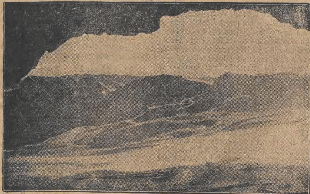
W Alpach bawarskich ukończono w tych dniach rycie tunelu w górze Zugspitze, długości 4½ km. Na zdjęciu: koniec tunelu, z którego widoczne są szczyty szwajcarskich Alp.
