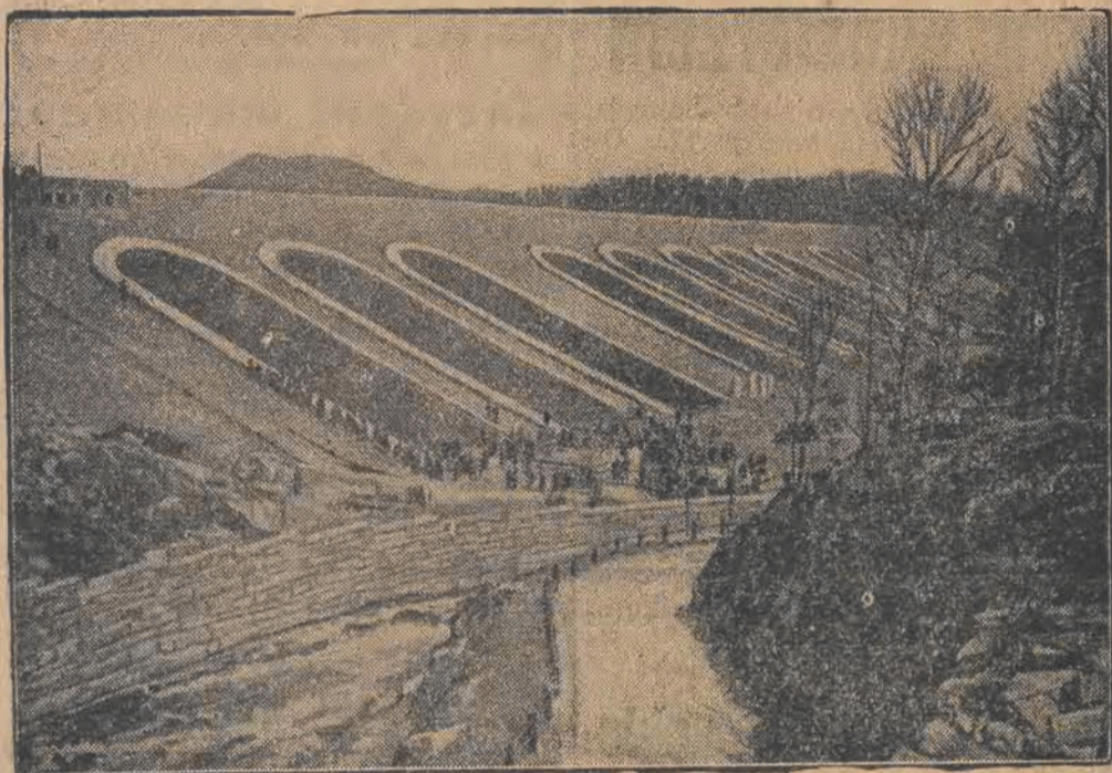
W stanie New Jersey (Póln. Ameryka) złożyło się osiem miast na budowę olbrzymiej tamy, widocznej na powyższym zdjęciu. Koszty budowy wyniosły 26 milionów dolarów.
