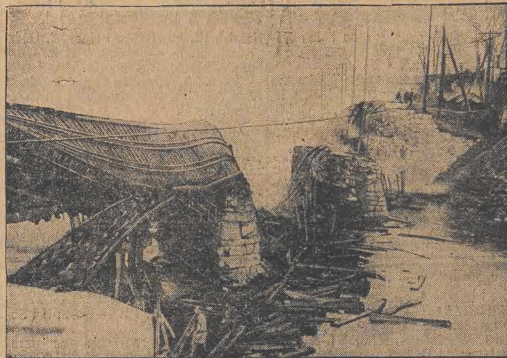
Jedna z licznych szkód — doszczętnie spalony most kolejowy
