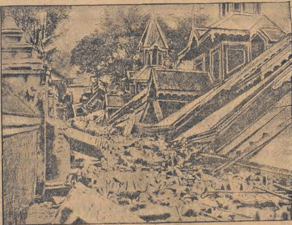
Widok ulicy w mieście Pegu (Birma); na ulicy tej runęło w gruzy kilka świątyń, grzebiąc pod sobą kilkadziesiąt ludzi.
