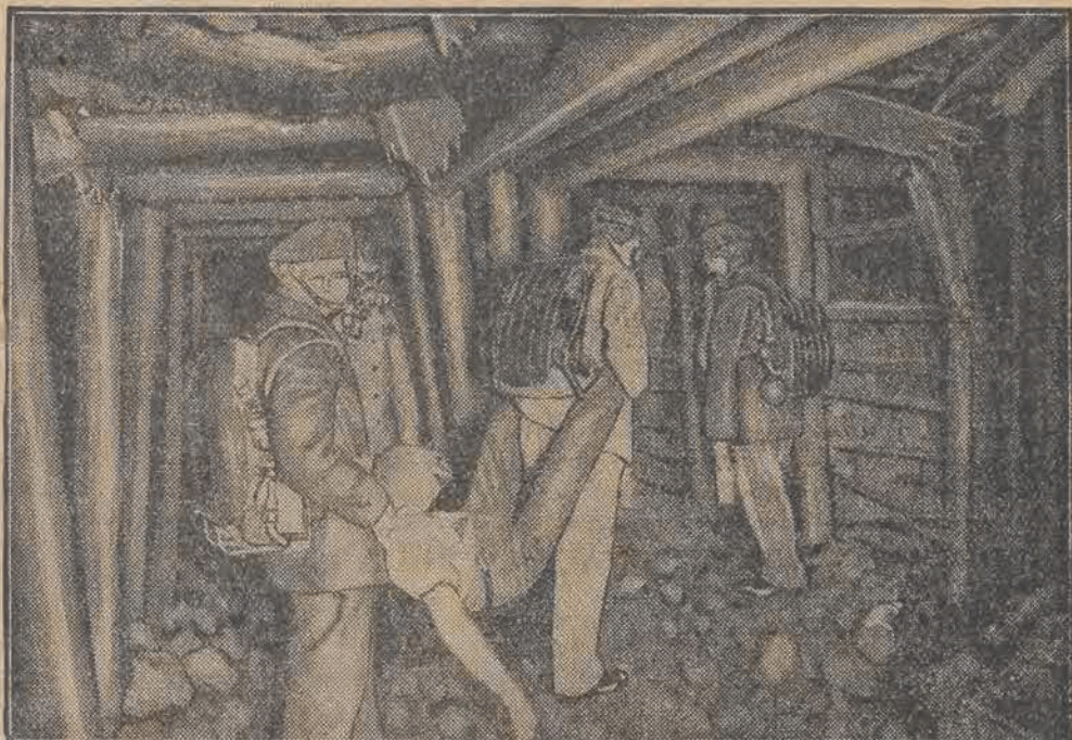
Prace ratunkowe w podziemiach, gdzie znalazło grób 187 górników.
