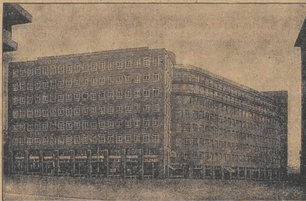
W Hamburgu ukończono budowę największego na świecie domu biurowego, posiadającego 600.000 metrów kwadratowych użytecznej powierzchni.
