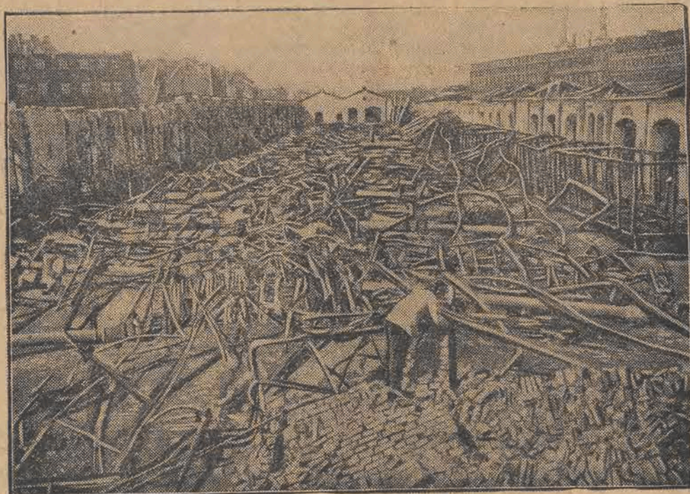
Na stacji w Hanowerze wskutek niewyjaśnionych przyczyn wybuchł pożar w pociągu towarowym. Znaczna część wagonów uległa kompletn. zniszczeniu.
