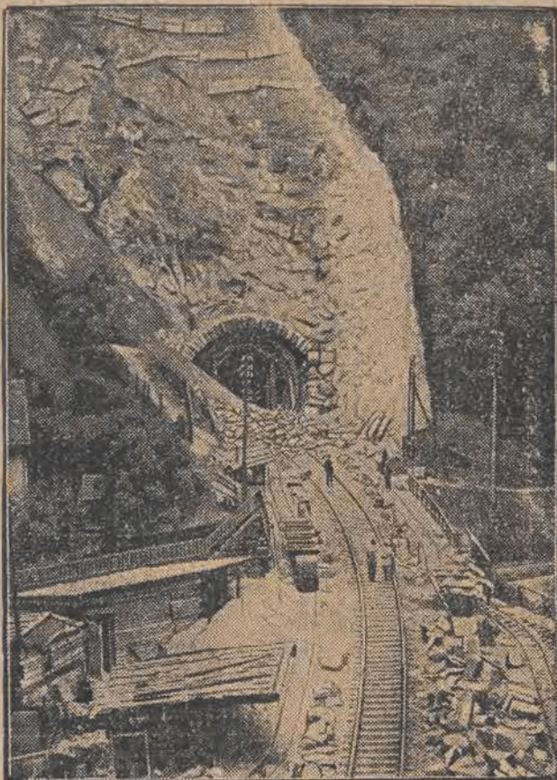
W Szwarzwaldzie w pobliżu miejscowości Triberg zawalił się tunel kolejowy, przyczem kilku robotników poniosło śmierć. Katastrofa nastąpiła wskutek ulicznych deszczów, które podmyły fundamenty.
