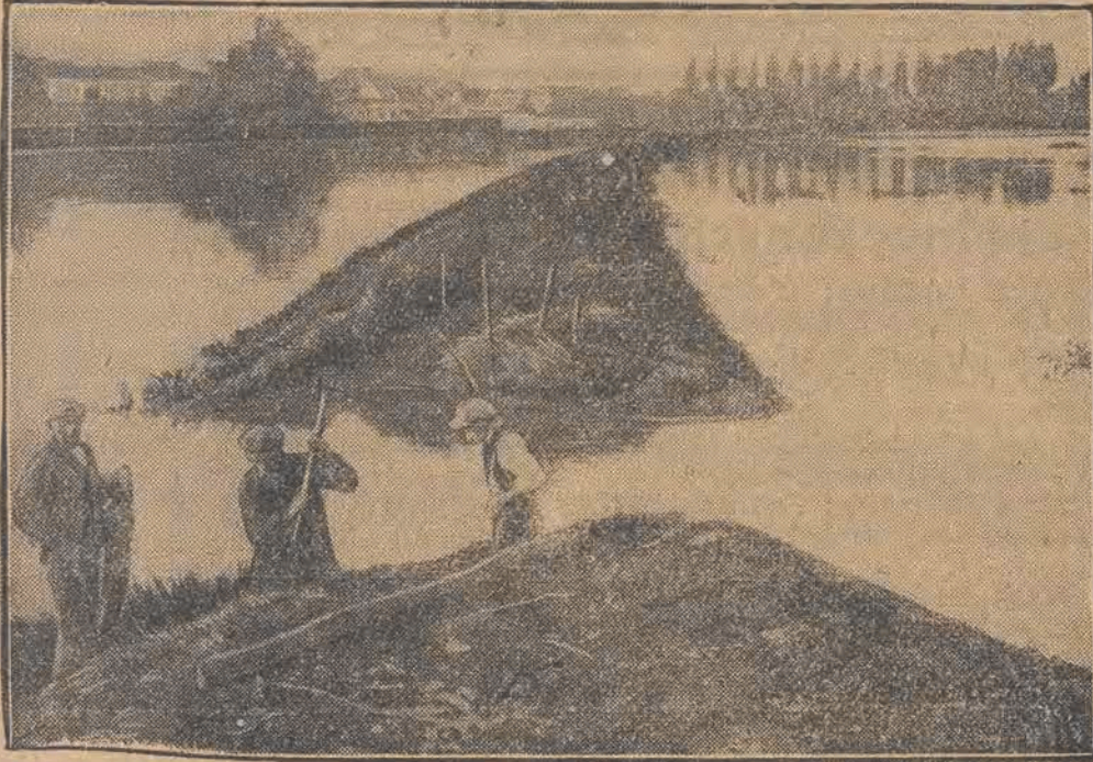
Olbrzymie wylewy rzek w Belgji spowodowały w tych dniach katastrofalne zerwanie tamy na rzekach. Wschodnia część Antwerpii została zalana wodą, która spowodowała kolosalne straty.
