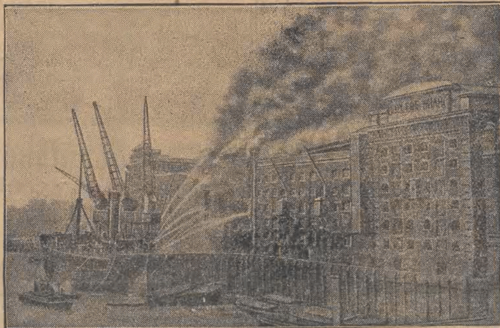
W Londynie, nad Tamizą wybuchł pożar w ogromnych składach towarowych, mieszczących się naprzeciwko Towertu. Mimo energicznej akcji straży, cały dom towarowy spłonął. Straty wynoszą 16 milionów złotych.
