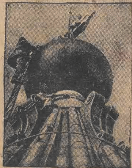
Rok rocznie, przed świętami Wielkiej Nocy, olbrzymia katedra Św. Piotra w Rzymie jest czyszczona gruntownie od dachu aż po portal. Na ilustracji — robotnicy na kopule katedry robią „porządki” przedświąteczne.
