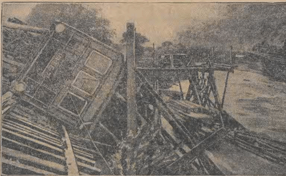
We Francji, w pobliżu miejscowości Modane, zawalił się mur ochronny, 25-metrowej wysokości i spowodował wykoślenie się pociągu osobowego. Szereg osób odniósł poważne rany.
