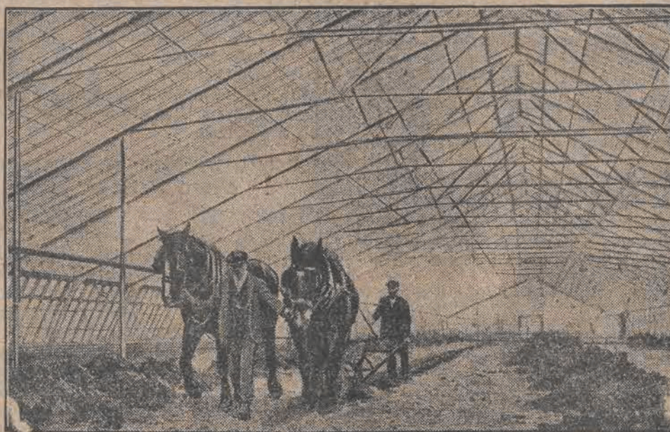
Na farmie doświadczalnej w Anglii, zbudowano na obszarze pola uprawnego wielki dach szklany, aby umożliwić za oranie i zasianie roli w porze zimowej.
