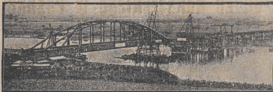
Na Elbie, w Tangermünde, zbudowano nowy potężny most. Most ten ma 110 metrów długości i waży 22.000 centnarów.
