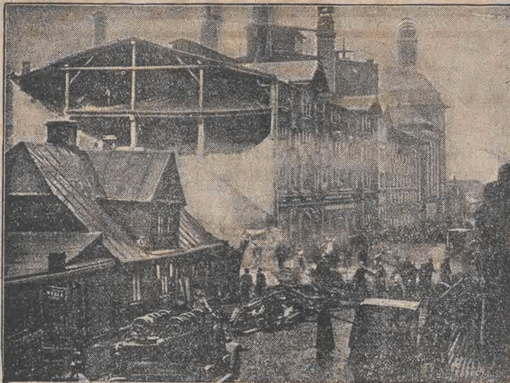
Ciekawe zdjęcie z katastrofy w Warszawie. Jak wiadomo, zawałiła się ściana szczytowa browaru „Haberbusch i Schiele”, grzebiąc pod gruzami 18 osób.
