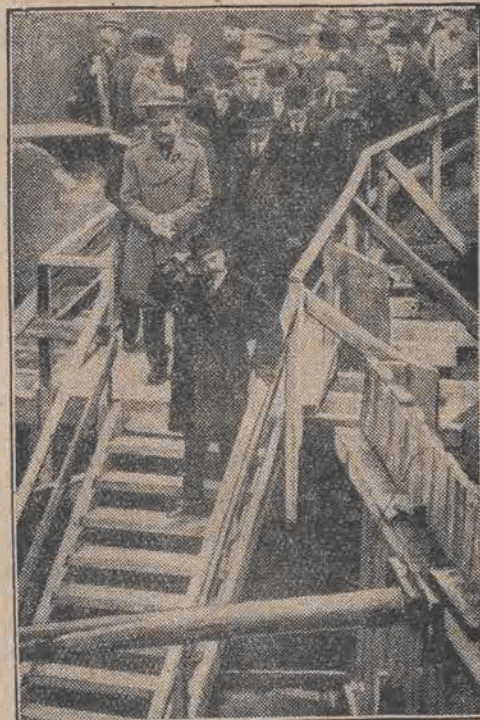
Król belgijski Albert dokonał w tych dniach poświęcenia budowy nowego tunelu pod Szeldą w Antwerpii.
