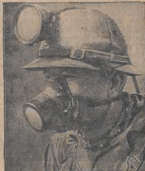
W czasie budowy olbrzymiego mostu z San Francisco do Oakland, robotnicy otrzymali helmy stalowe i maski gazowe, upodobniające ich zewnętrznie do żołnierzy frontowych.
