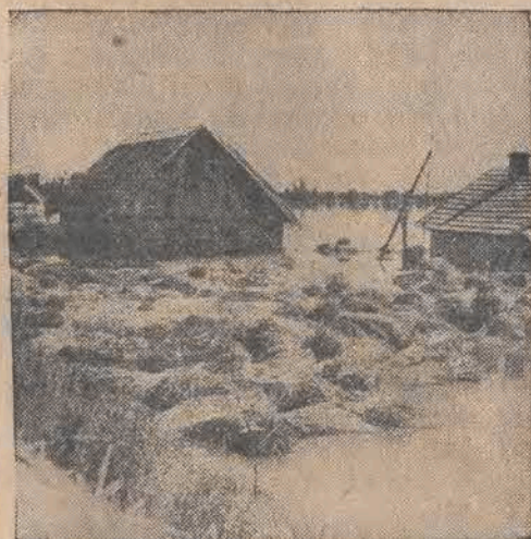
Zalane chaty, zniszczone zbiory.
