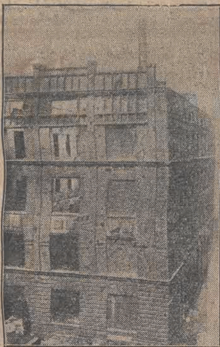
Mury fabryki po pożarze.
