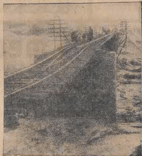
Północno-zachodnia część Japonii nawiedzona została katastrofą powodzi. Dotychczas nurty porwały przeszło 100 osób. Na zdjęciu widzimy podmyte tory kolejowe.
