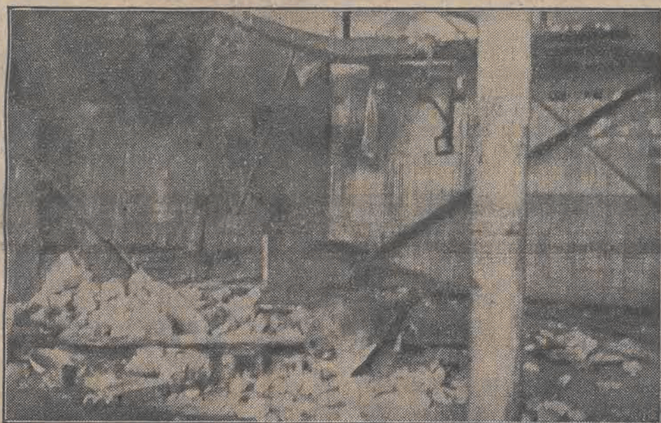
Zdemolowane wnętrza piekarni Berenta a skutkiem eksplozji 2-ch kotłów.
