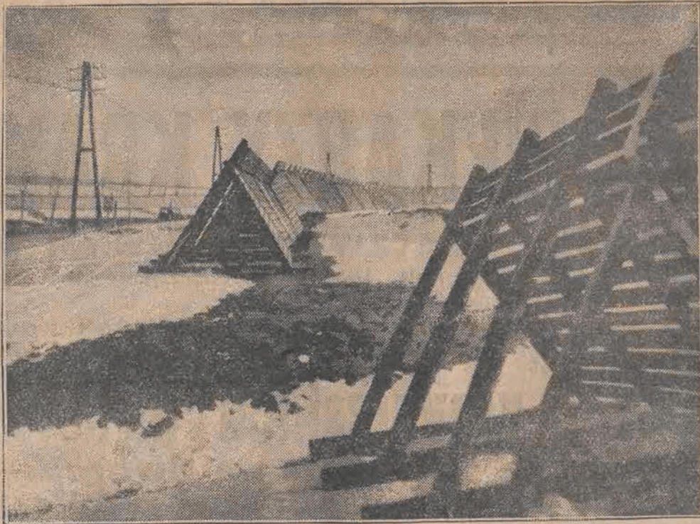
W górach Harzu zbudowano specjalne płoty drewniane jako ochrona przed śnieżycami, które umożliwiają w ten sposób komunikację na drogach.
