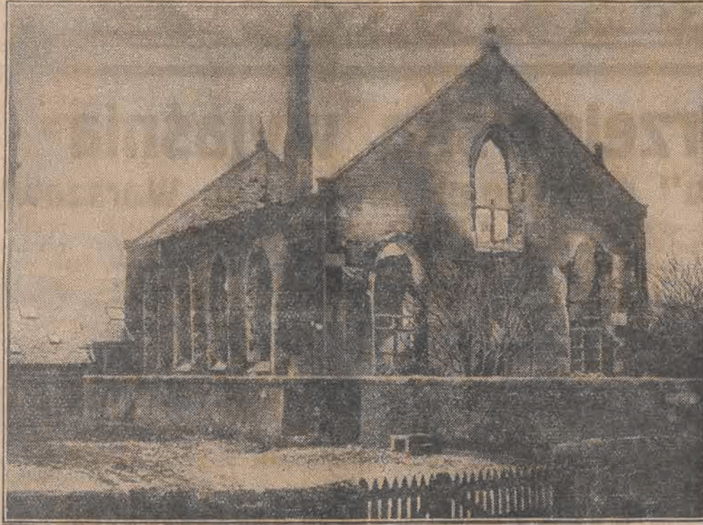
W Anglii przed kilku dniami szalały straszne nawałnice, które wyrządziły nieobliczalne szkody. — Na zdjęciu widzimy kościół w Szkocji, zniszczony wskutek burzy.
