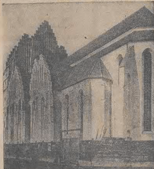
Śmiały w koncepcji architektonicznej kościół w jednym z miasteczek duńskich koło Kopenhagi. Budowa kościoła jest na ukończeniu.
