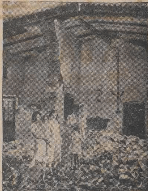
Zniszczony budynek kolejowy w Quetta.
