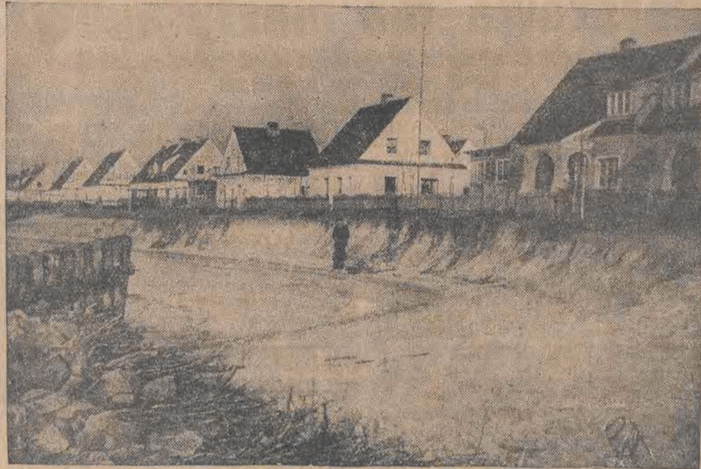
Po ostatniej burzy półwysep helski w okolicach Małej Plaży koło Helu przedstawia widok ogromnego zniszczenia. Woda podmywając piasek grozi spiókaniem wybrzeża, na którym ciągnie się Aleja Nadmorska. — Na zdjęciu widok na zniszczony odcinek Małej Plaży pod nową kolonią rybacką, na pierwszym planie wielka wyrwa i zagrożone runięciem domy.
