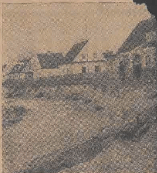
Zabezpieczone workami brzegi Małej Plaży na Helu znowu zostały podmyte. Fale zabrały umacniające wyrwy worki z piaskiem i znaczny znowu kawał brzegu. — Na zdjęciu — widok ponownych zniszczeń na Małej Plaży na Helu.
