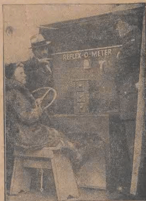
W Stanach Zjednoczonych wprowadzono próby sprawności szoferów. Strzała na specjalnym przyrządzie notuje każdy nieostrożny i nierozważny ruch kierowcy.
