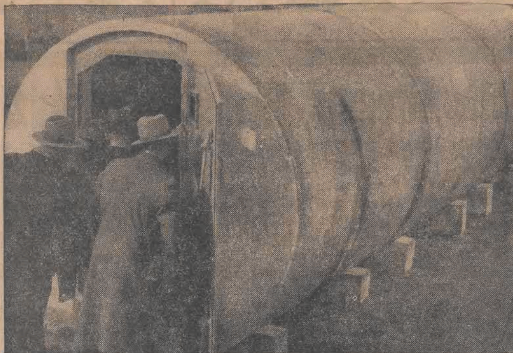
W Lipsku zademonstrowano oryginalny schron przeciwlotniczy, w kształcie walca metalowego.
