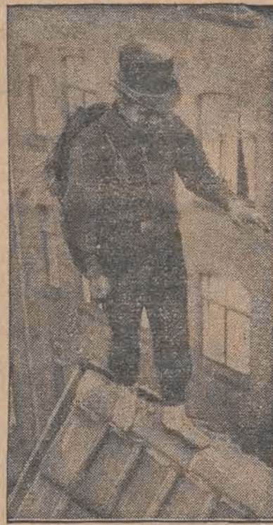
Niebezpieczny „spacer“ kominiarza po dachu domu.
