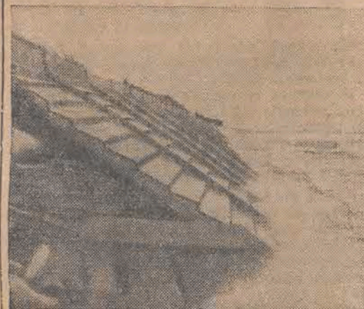
Panujący na wybrzeżu w ciągu ostatnich dni sztorm przy bardzo wysokim poziomie wody przekraczającym 1 mtr. ponad stan normalny poczynił znaczne szkody na całym wybrzeżu. — Na zdjęciu widzimy masywną tamę betonową, systemu holenderskiego pomiędzy Karwią a Karwińskimi Błotami kompletnie rozbita przez fale morskie.
