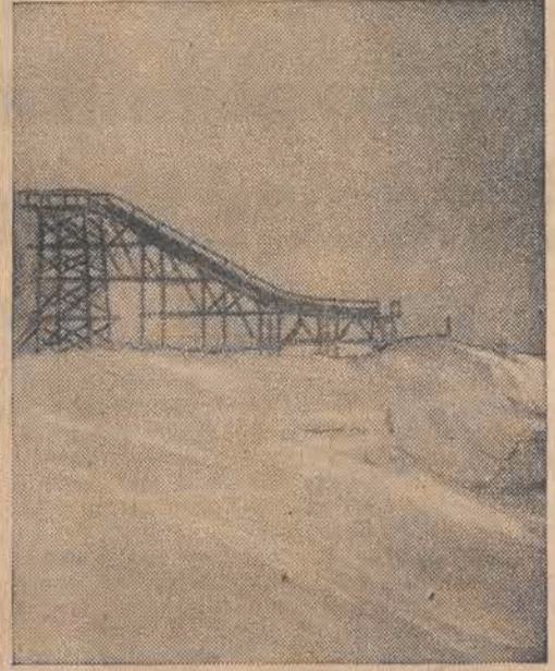
Reprodukujemy zdjęcie, przedstawiające wybudowaną ostatnio w Łucku na Wołyniu nową skocznię narciarską.
