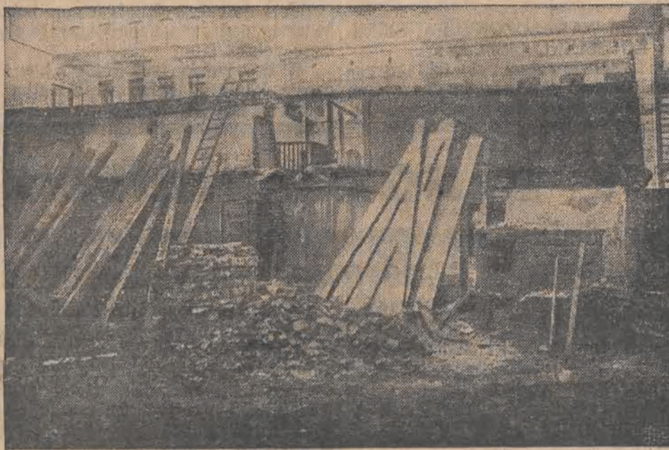
Rozbiórka domku przy ul. Piotrkowskiej. Widok od strony podwórza.
