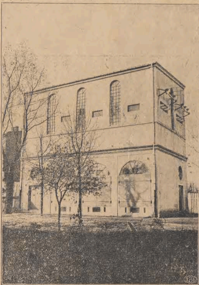
Główny transformator elektryczny przy ulicy M. Barucha w Pabjanicach.
