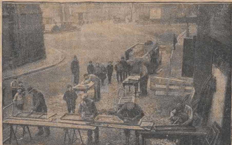
W Neunkirchen, które uległo tak strasznej katastrofie, już rozpoczęto prace, zmierzające do odbudowy miasta.
