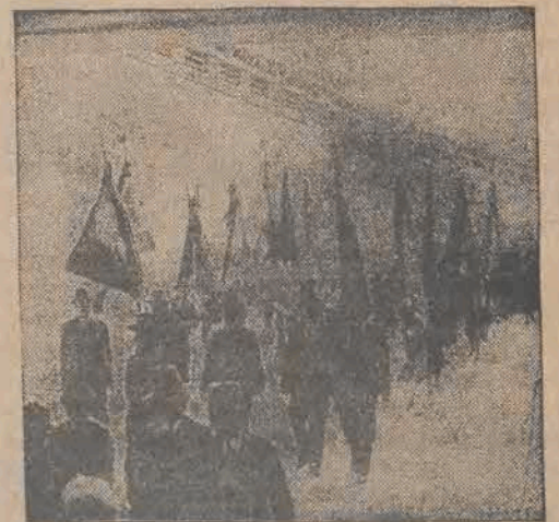
W tych dniach otwarto uroczyste w Antwerpii tunel, przeprowadzony pod rzeką Skaldą, będący prawdziwym arcydziełem techniki nowoczesnej. Na zdjęciu moment z uroczystości otwarcia tej nowej arterji komunikacyjnej. Pochód, złożony z przedstawicieli rozmaitych organizacji, wkracza do tunelu.
