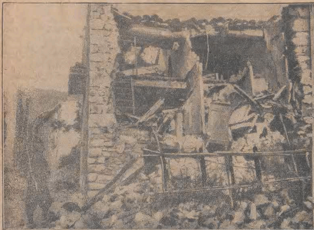
Trzęsienie ziemi, jakie nawiedziło włoską prowincję Abruzję, wyrządziło poważne szkody. W 24-ch włoskich 400 domów zostało doszczętnie zniszczonych. 900 silnie uszkodzonych, zaś w 3000 zabudowaniach — zarysowały się mury.
